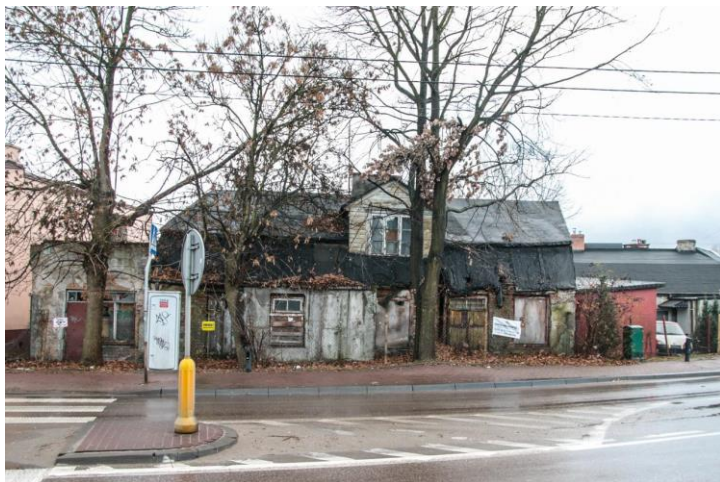
Fotografia 6. Budynek przy ul. ks. Skorupki 2
