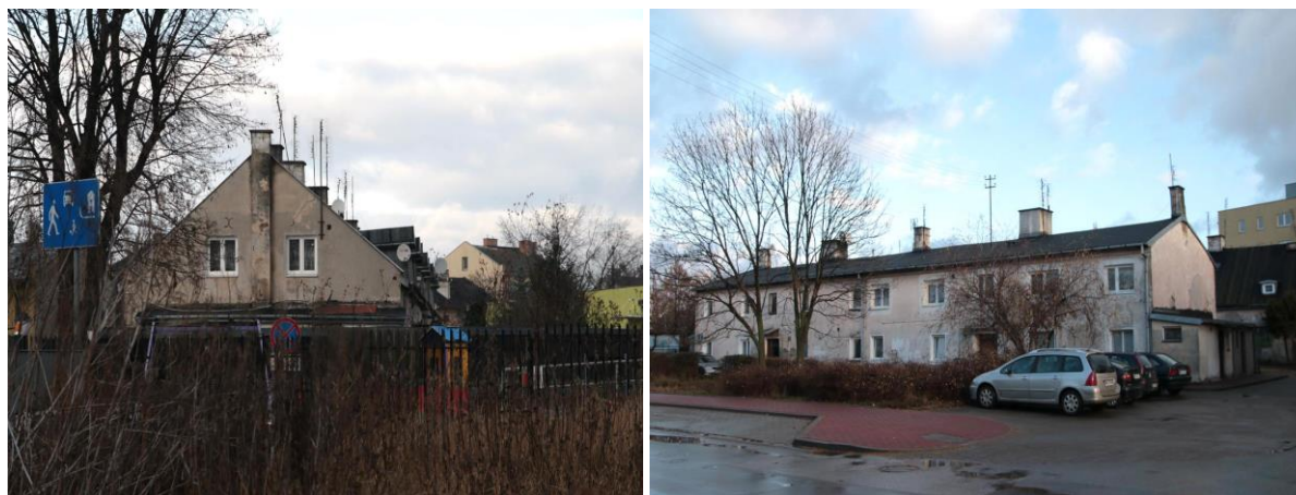
Fotografia 15. Budynki komunalne przy ul. Piłsudskiego 5 i 5a przeznaczone do wyburzenia
