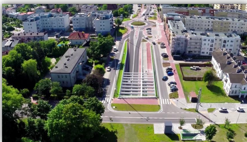
Rysunek 16 Tunel pod przejazdem kolejowy na ulicy Orlej
